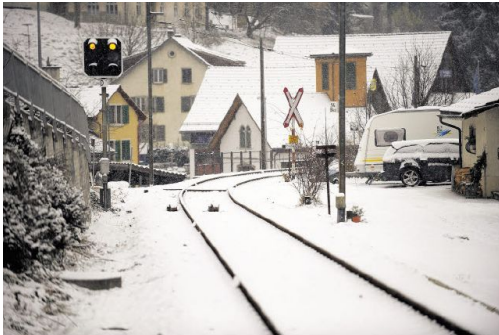
Das Gleis durch das Hinwiler Dorfzentrum wird heute nur vom Dampfbahn-Verein Zürcher Oberland genutzt. Bild: Karin Hofer / NZZ
